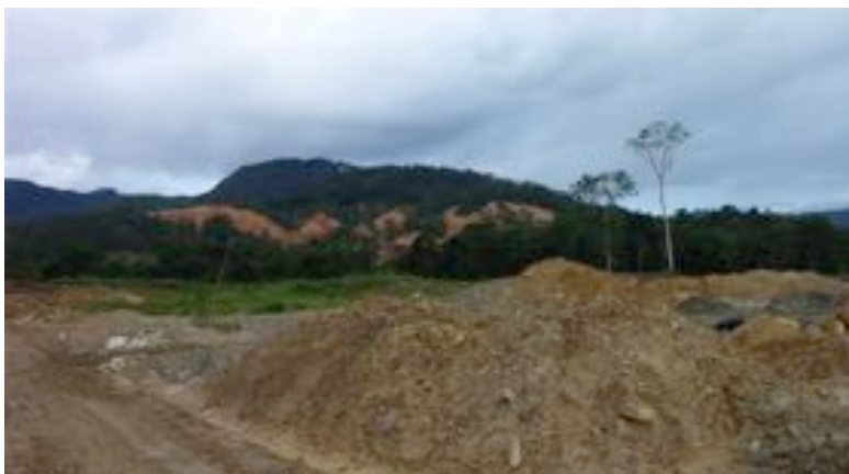
Trabajos de desbroce iniciados por la empresa. Foto: diario de campo.
